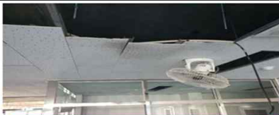
비닐 보양 전 임의 철거(2)
