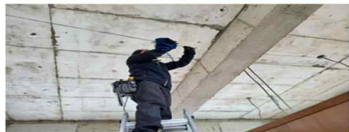
보양 비닐 철거 후 청소
