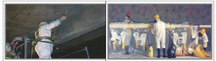
〈그림 4〉 분무된 봉질재 제거작업(좌)과 글로벌백을 이용 파이프 보온재 제거 모습(우)
