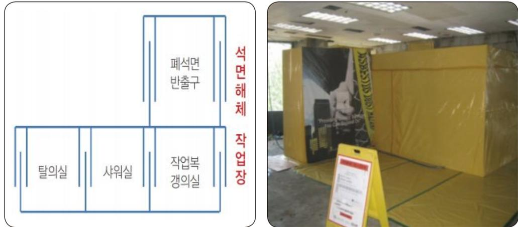
[그림 30] 석면폐기물 반출구 설치 예시
